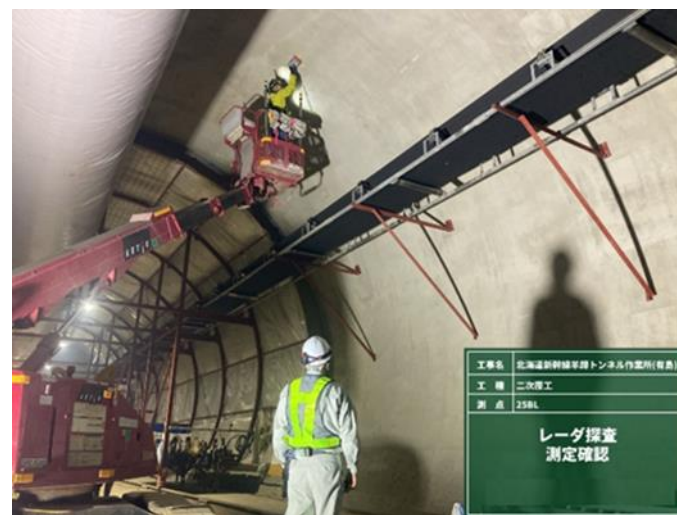
覆工電磁波レーダー探査による空洞調査
