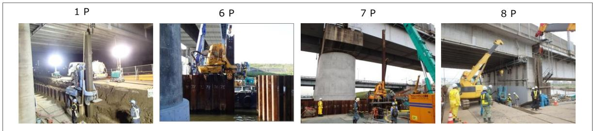
仮締切材の引抜き、残置箇所のイメージ図
