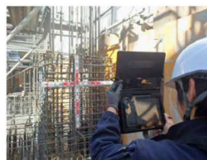
(配筋写真撮影状況)
