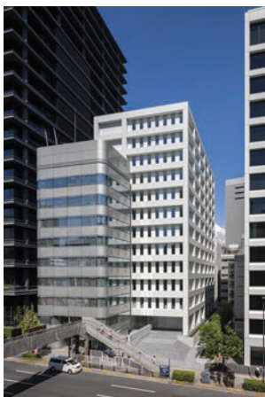
「KT ビル」外観（遠景）
