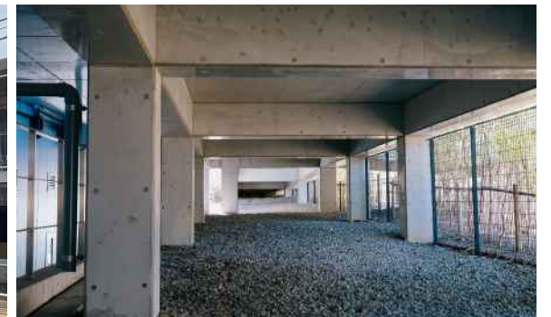
汎用性が高くCO2排出量を約20%削減する環境配慮型コンクリート「H-BAコンクリート」
