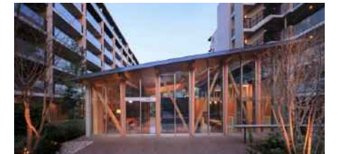
木造共用棟の建設 ルネ横浜戸塚
