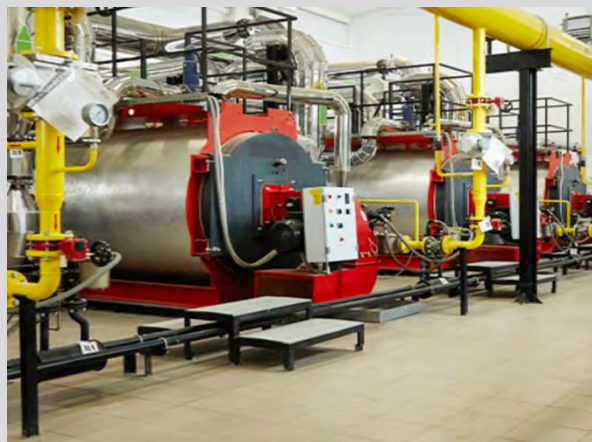
ボイラー交換工事
