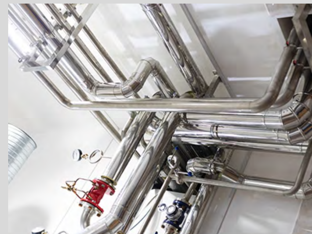
空調給排水衛生工事
