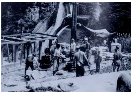
1963年 黒部ダム 電気工事完工
