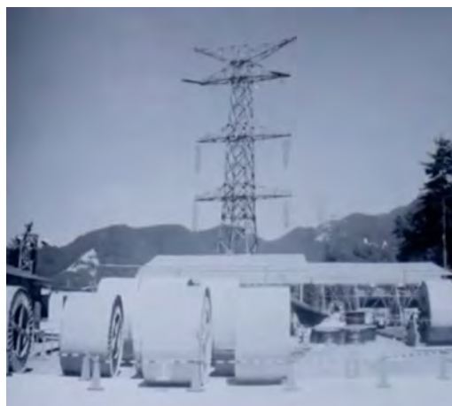
1988年 国内初100万ボルト 送電工事受注
