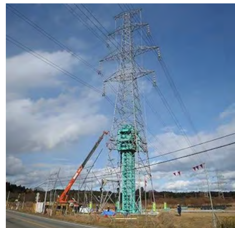
2016年 鉄塔嵩上げ装置「エナーク160」を開発、特許権を取得
