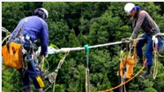
送電線架線工事の様子
