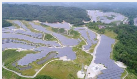
大規模太陽光発電の工事
