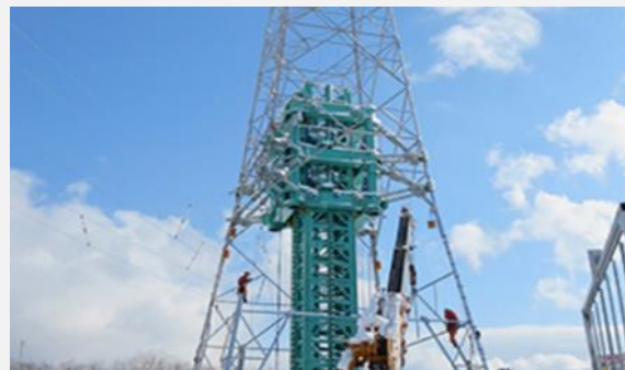
鉄塔高上げ装置(特許取得済)
