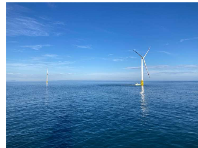
洋上風力発電設備全景
