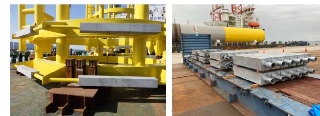
ケージに取り付けられたアルミニウム合金陽極
