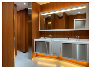
エムズ NBF渋谷イーストビル トイレ改修工事
