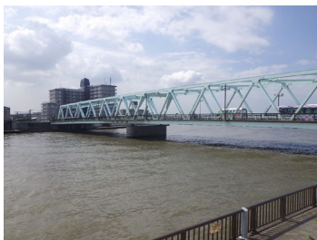
青木マリーン 本奥戸橋補修工事（橋脚補強） その2
