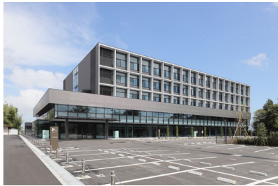
青木あすなろ建設 水戸法務総合庁舎（18）建築その他工事
