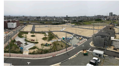
青木あすなろ建設 堺市白鷺町Ⅰ・Ⅱ宅地造成工事
