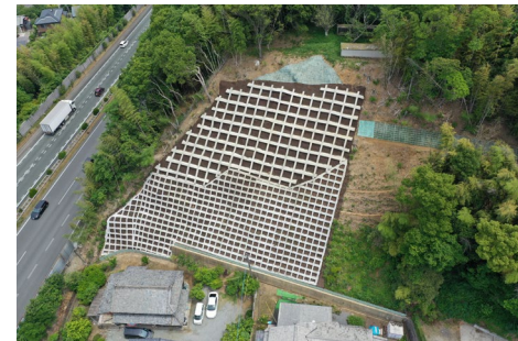
東興ジオテック 御井校区斜面对策工事
