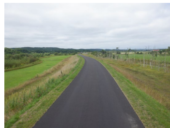
あすなろ道路 釧路川改修工事の内 磯分内築堤外天端保護工事
