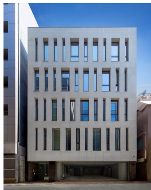
高松建設 銀座 山勝ビル新築工事
