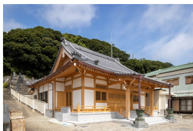
金剛組 横須賀法善寺本堂新築工事
