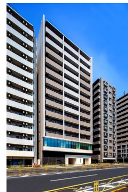
高松建設 立会川 大井交通(株)マンション 新築工事
