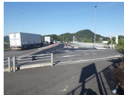
東興ジオテック 国道2号長谷川橋外橋梁補修工事
