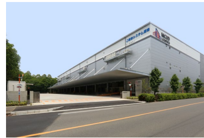
青木あすなろ建設 （仮称）鶴ヶ島物流施設計画新築工事
