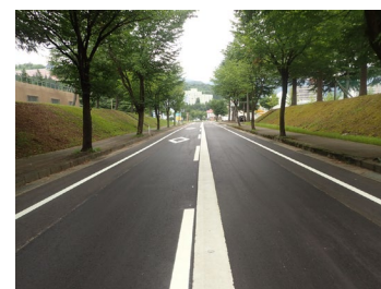
新潟みらい建設 維持改第2号原新田小坂線 舗装打替工事
