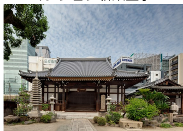
金剛組 源光寺本堂改修工事
