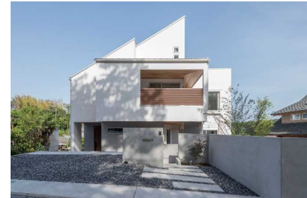
タツミプランニング 施工物件
