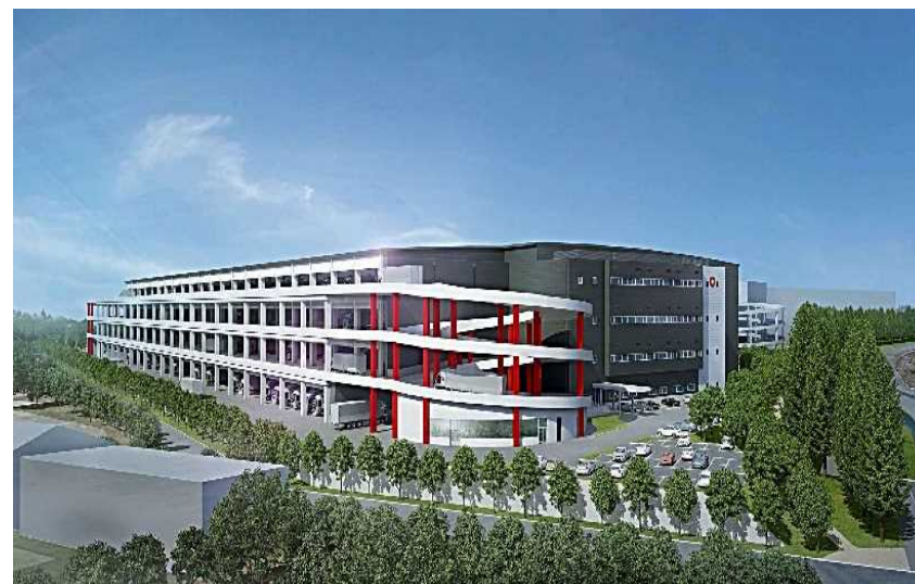
DPL流山 I (青木あすなろ建設とのJV)
