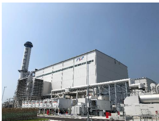
発電所地上から (手前が2号機、右奥が1号機)
