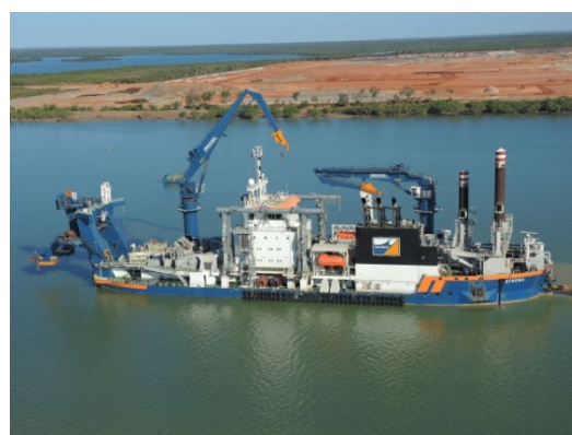
浚渫作業の様子
