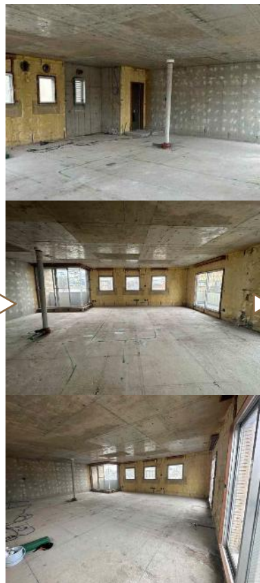
<スケルトン工事>
