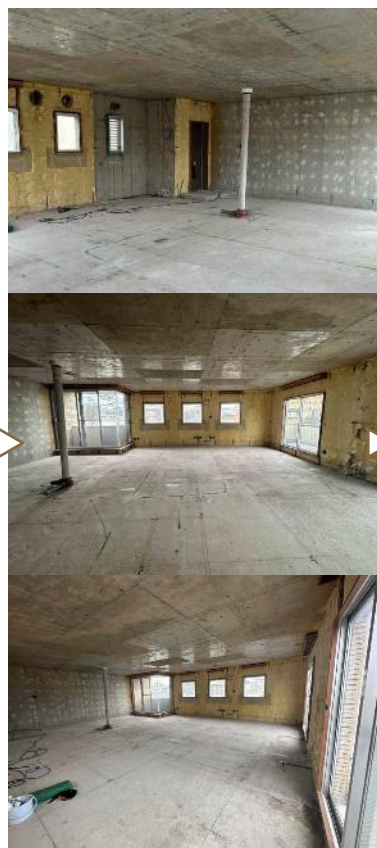
<スケルトン工事>
