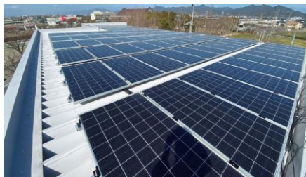
営農型太陽光発電所※1
