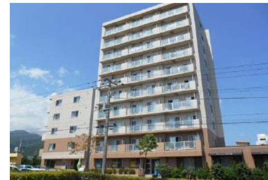
自立シニア向け介護事業施設 北海道札幌市 (サービス付き高齢者住宅)
