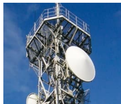
▲防災行政無線工事
