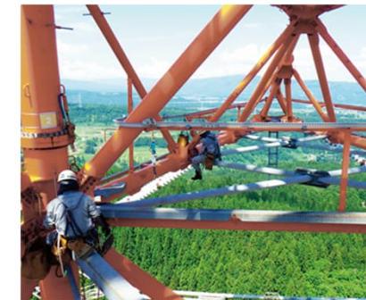
▲架空送電線設備保守業務委託工事
