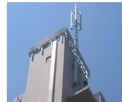
▲移動体通信工事
