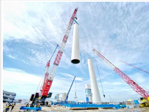
クレーン（洋上風車組み立て）
