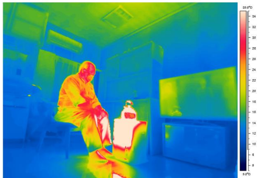
断熱+気密改修前
