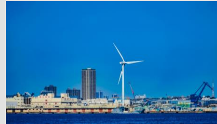
国家的重要施設
