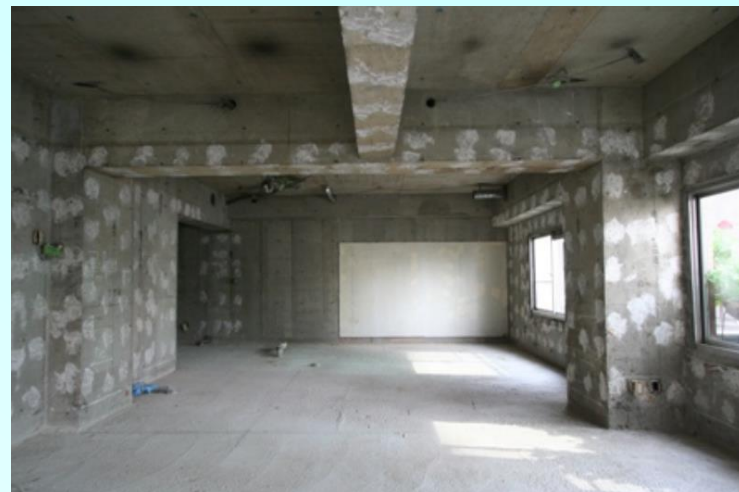
無断熱の躯体
