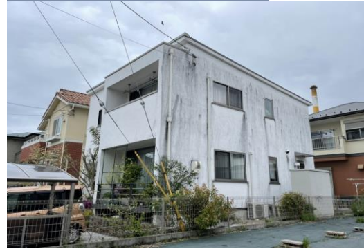
施工前 戸建て住宅
