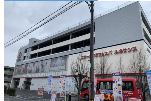
施工後 スポーツクラブ
