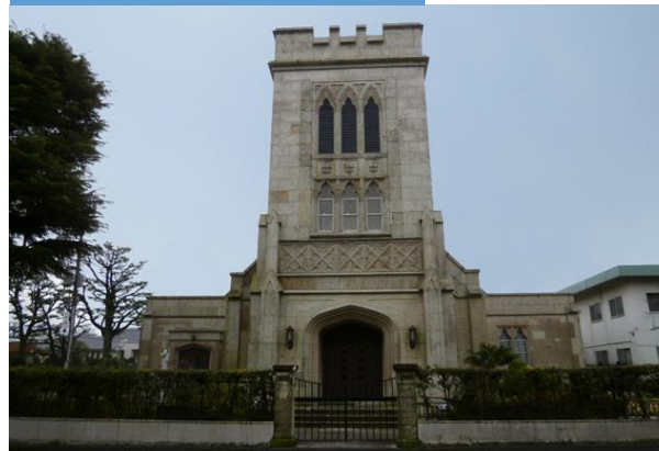
施工後 歴史的建造物
