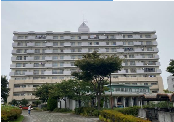
施工後 集合住宅
