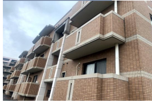
施工前 アパート
