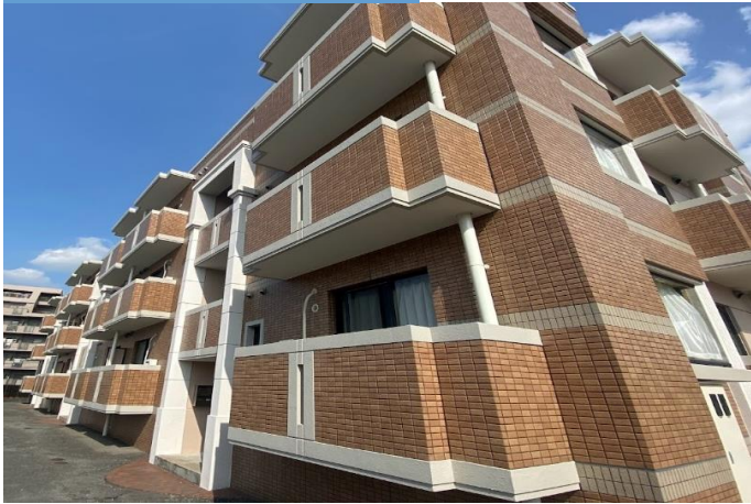
施工後 アパート
