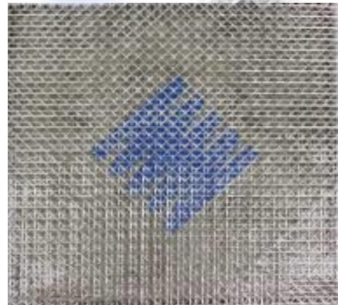
ガラス連続繊維シート貼付け
