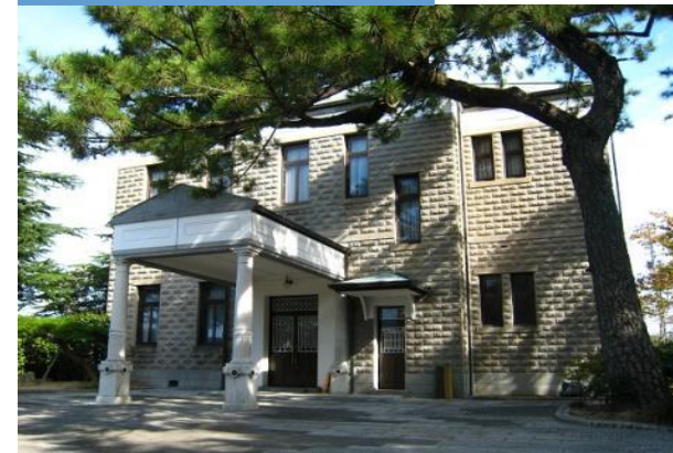
施工後 国有文化財
