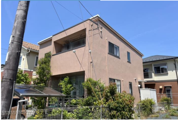
施工後 戸建て住宅
