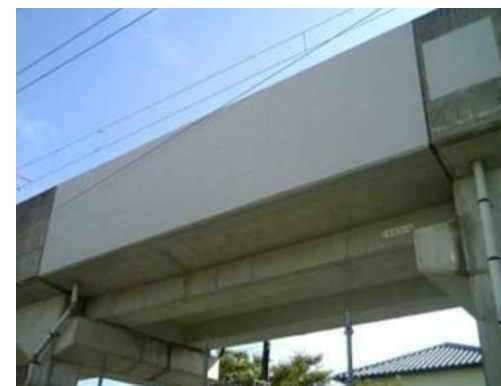
はく落防災コーティング
