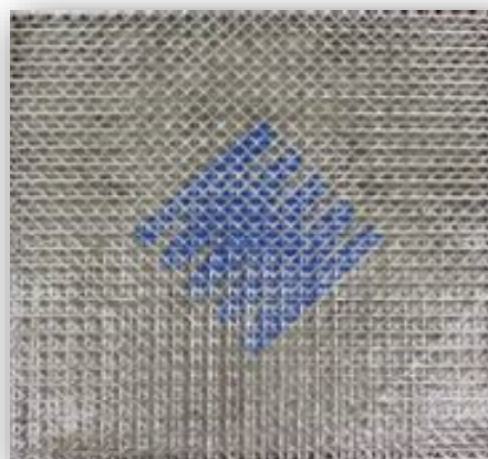
ガラス繊維シート貼付け・含浸
