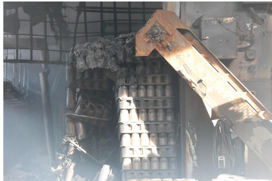
作業棟内部（手前：きのこ栽培ビン）
