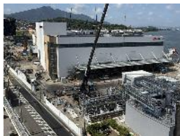
(北九州)新工場の 建設の様子
