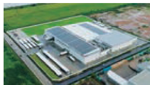
太陽光発電設備導入 (国内外食品、他)
